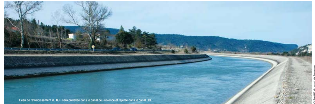
L'eau de refroidissement du RJH sera prélevée dans le canal de Provence et rejetée dans le canal EDF.
