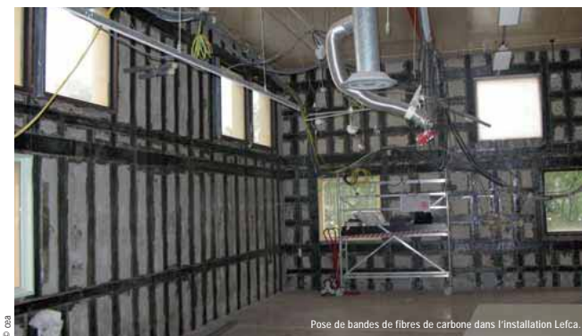
Pose de bandes de fibres de carbone dans l'installation Lefca.
