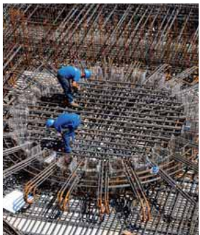
Ferrailage du radier en béton armé sous les cuves de la nouvelle installation Agate.
