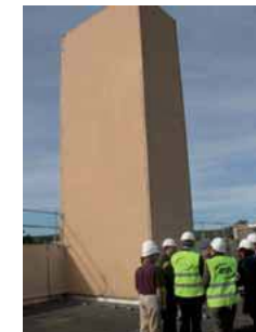
Inspection de l'ASN sur le chantier de rénovation parasismique du Lefca à Cadarache.
