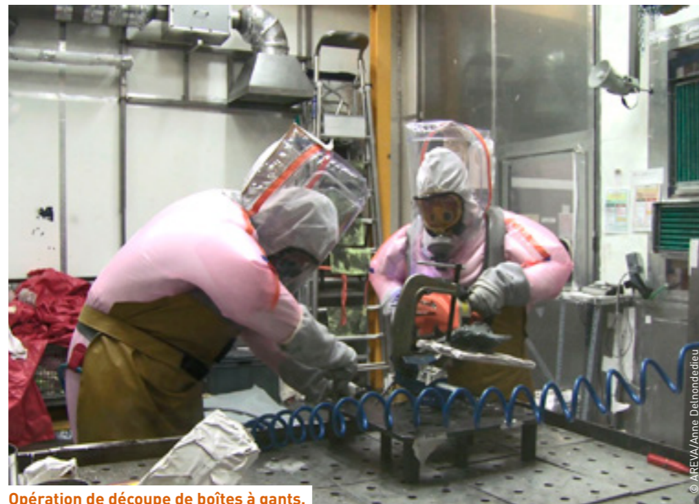
Opération de découpe de boîtes à gants.
