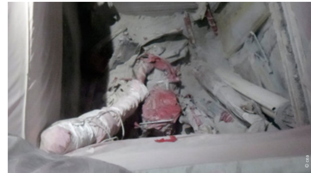
Une fosse du chantier de reprise des déchets « historiques ».
