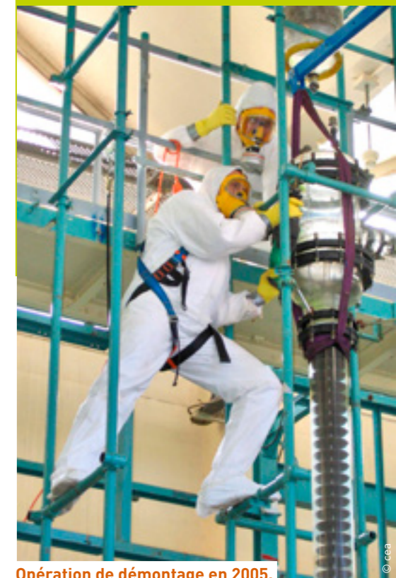
Opération de démontage en 2005.
